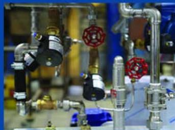
جهت ایمنی مخازن از شیرهای اطمینان قابل تنظیم استفاده می شود
